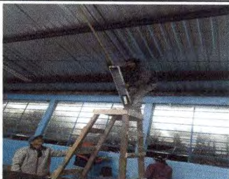
Foto 3: Sustitución de plafoneras
