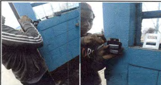
Foto 4: Sustitución de interruptores simples y dobles
