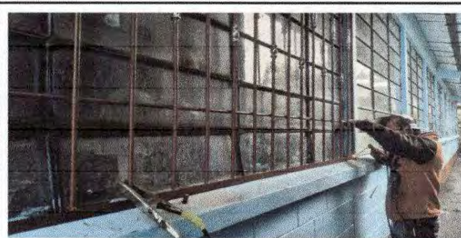
Foto 5: Sustitución de balcones de metal
