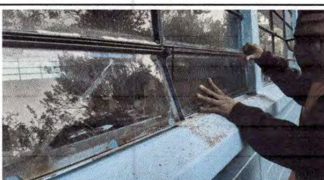
Foto 4: Sustitución de vidrios
