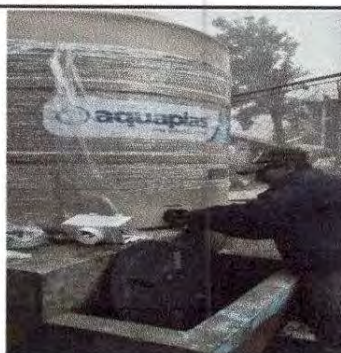
Foto 6: Sustitución de depósito de agua 1700 lt
