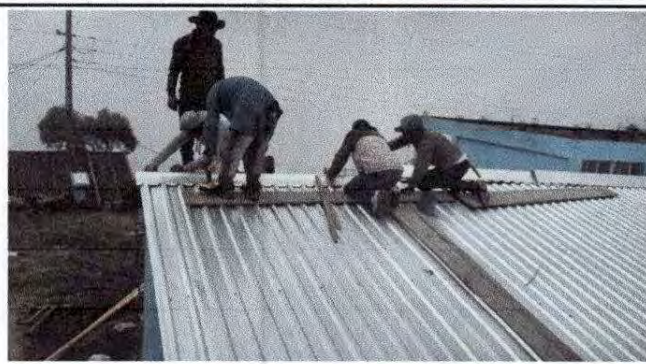
Foto 2: Sustitucion de capote de lámina para lámina troquelada
