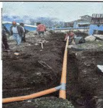
Foto 5: Sustitución de tubería PVC linea principal aguas negras
