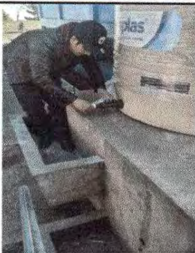
Foto1: Sustitución de llave de chorro
