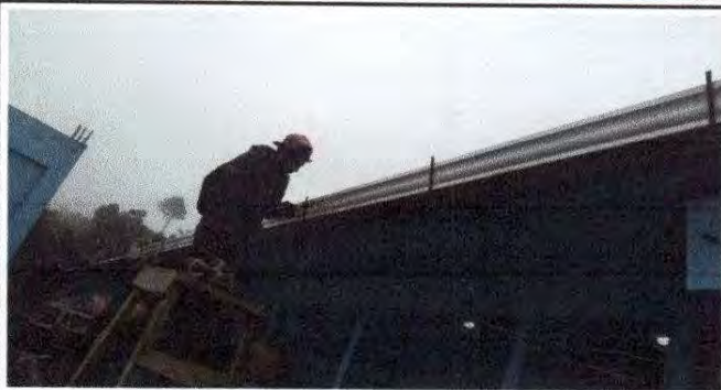
Foto1: Sustitución de canal de pvc
