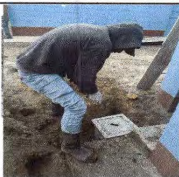
Foto 6: Sustitución de caja de registro
