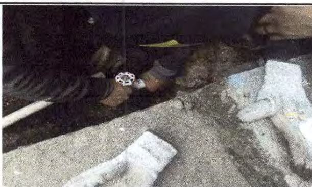
Foto 4: Sustitución de llave de paso
